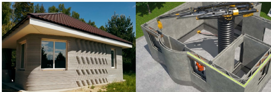
Рис. 4. Пример печати на 3D-принтере жилого дома
